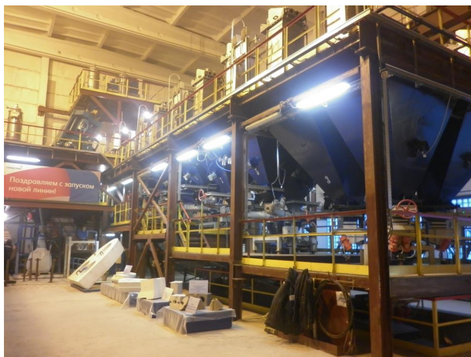
Рис. 3 Линия приготовления торкретмасс и сухих огнеупорных смесей. г. Череповец
