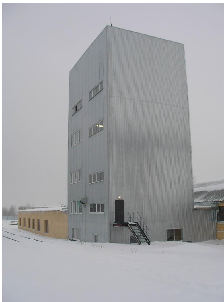
Рис. 5 Здание с вертикальной компоновкой оборудования ДСЛ приготовления сухих огнеупорных смесей. г. Коломна
