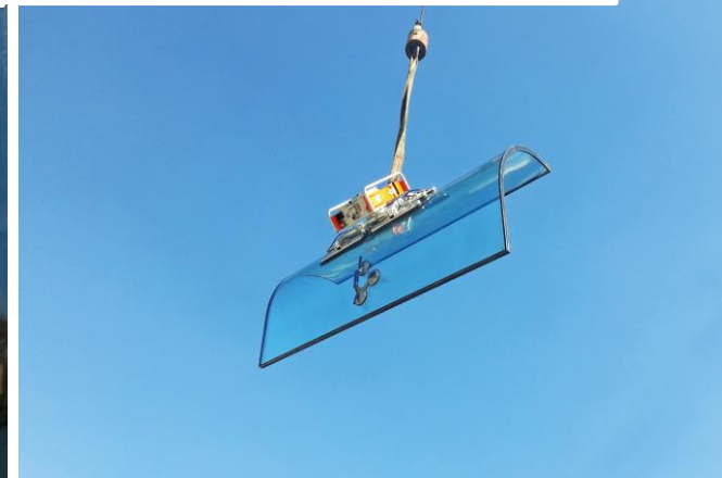
МОНТАЖ РАДИАЛЬНОГО СТЕКЛА
