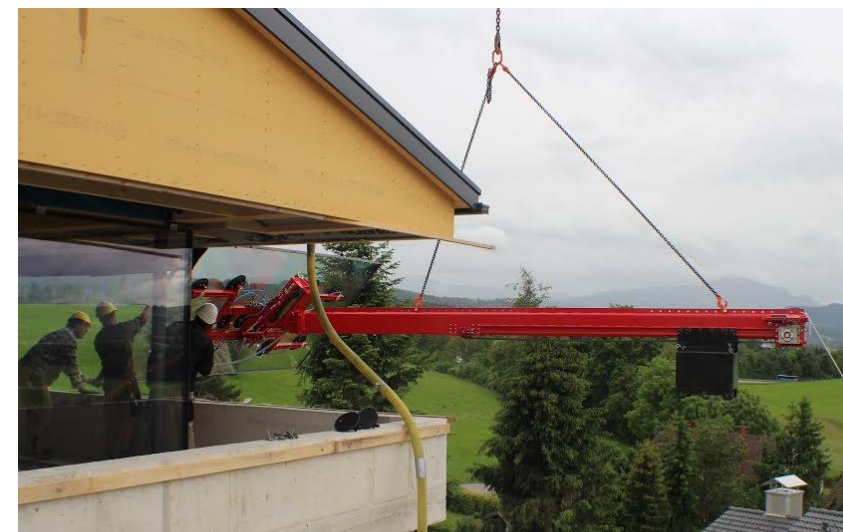
МОНТАЖ СТЕКЛА ПОД КОЗЫРЁК
