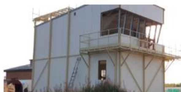
ДЕМОНТАЖ СТАРЫХ СТЕКЛОПАКЕТОВ И УСТАНОВКА ГРЕЮЩИХ ОКОН В АЭРОПОРТУ "СОЛОВКИ" НА
