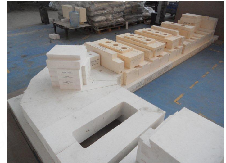
Кирпич CUMIZITE при окрашивании в канале питателя
