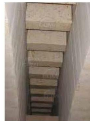
Опорная арка из силлиманита - CUMILITE 60A SPL
