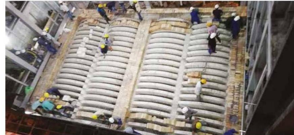
Строительство опорной арки на месте
