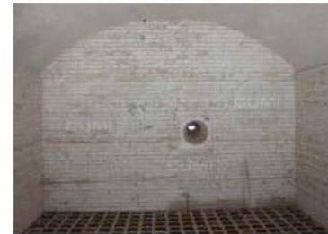
Кирпичи из плавяного муллита для боковой стены, настильной стены и свода - CUMILITE WHF
